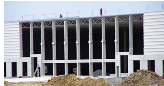
Zastosowanie elementów prefabrykowanych firmy Fabud WKB S.A. do budowy hali
